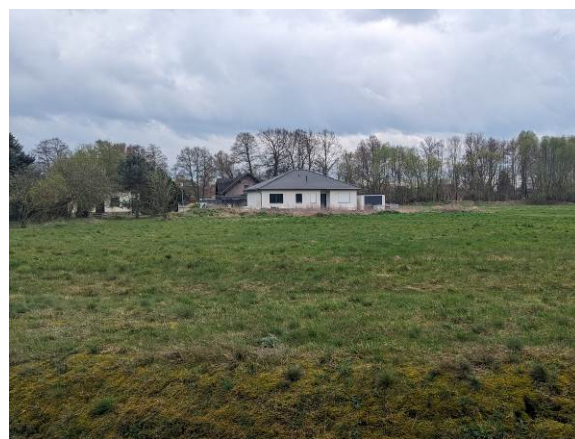
Abbildung 10: Blick von der L121 auf den bebauten Bereich des östlichen Geltungsbereiches der 1. Änderung.
